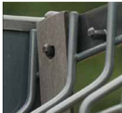
Les lattes sont fixées grâce à des réglettes
